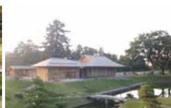
ほぼ完成している休憩所
