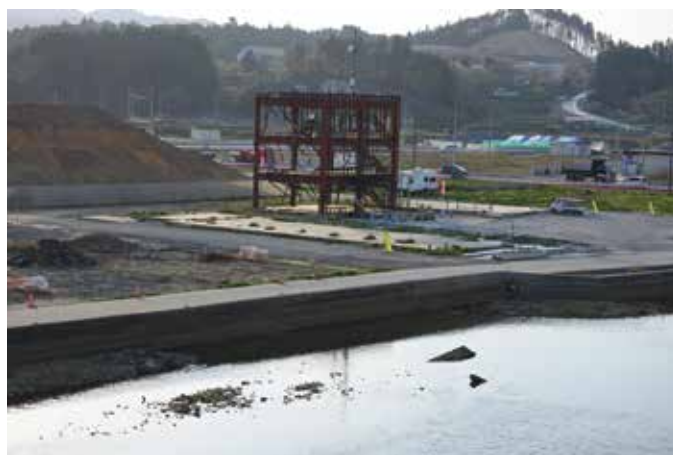
（南三陸町防災対策庁舎：宮城県南三陸町）
