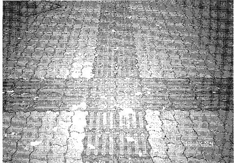
敷いてあるインターブロック間の溝が誘導ブロックの凹凸と区別しにくく、結果として誘導ブロックを発見しにくくしているためである。また、②で問題になるのは、図1で示したcの誘導用ブロックが、a bの注意喚起のブロックと足で踏んだとき識別しにくいことである。結果として、歩く方向を示しているのか、注意を喚起しているのかが視覚障害者に伝わりにくく、本来の目的を達成できないのである。
