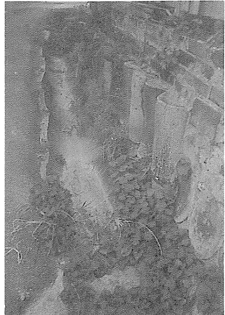
下部に土管（陶管）など、その上をレンガで固めた擁壁。溝には土管の半割を利用していている。草も適度に生えて自然らしい。
