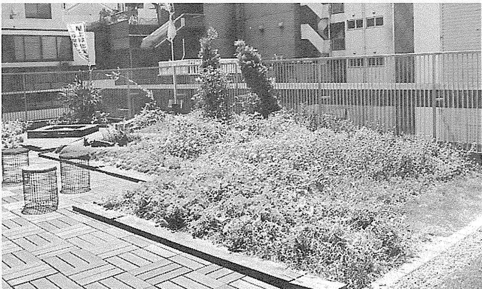
写真5：吸水材混入土壤を使った例（神南庁舎）
