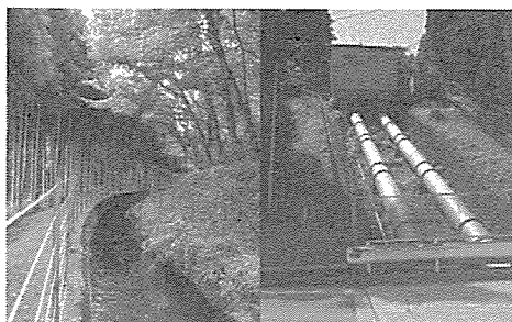
図11 鳴瀬川水系から門沢発電所に向かう水路と機械室上部の水圧管路(加美町)
