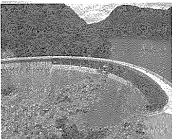
図9 江合川上流に建設された鳴子ダム(大崎市)
