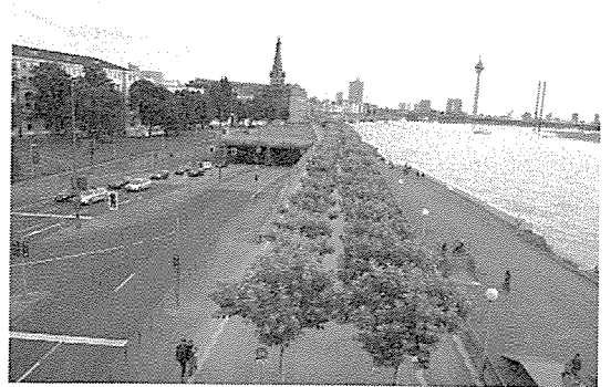
写真8 地下化された道路が地上に出るところ
