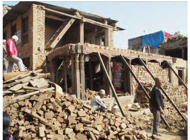
がれきの出ない煉瓦の再利用（バクタプル）
