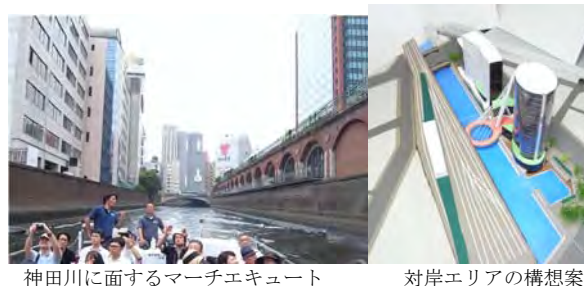
神田川に面するマーチエキュート
