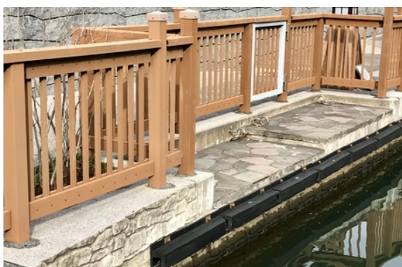
図9 係留用設備のない船着場（小名木川）
