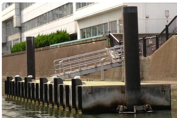
図3 浮棧橋(神田川・和泉橋防災船着場)
