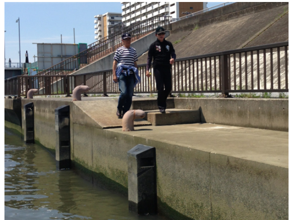
図4 階段状固定棧橋(中川・西新小岩船着場)
