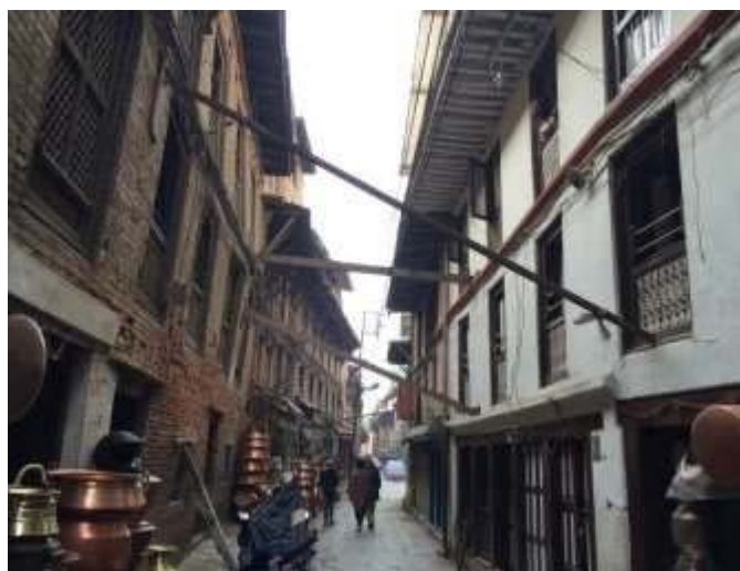
写真2 道路を挟んで相互に支え合う建物（バタン）
