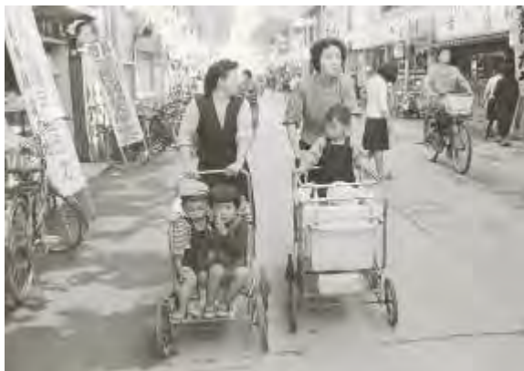
▲山口県内で初となるアーケードが昭和32年に建設された(昭和59年撤去)
