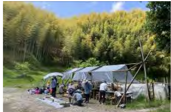
竹を組んで日よけシートの休憩舎を作った。
