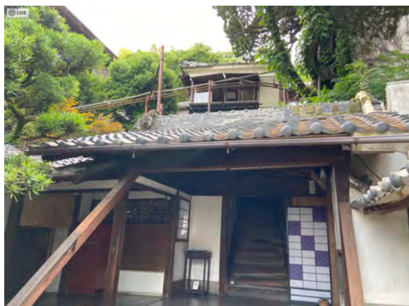
斜面を登るように建つ料亭・望州楼
