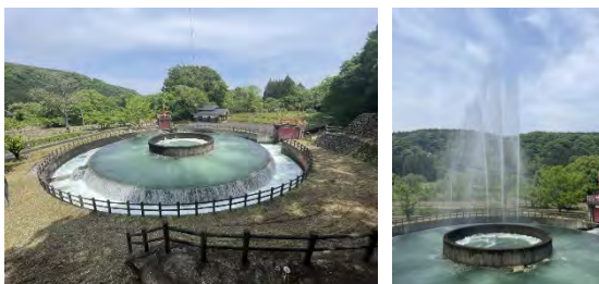
写真-2・3. 徳水園円筒分水工
