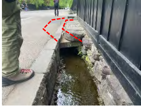
写真-20. 敷地内の巨木の根を避け側溝を迂回して整備
