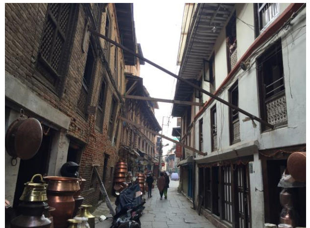
道路を挟んで相互に支え合う建物（バタン）
