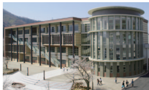
3 仁愛大学人間学部棟および食堂棟
